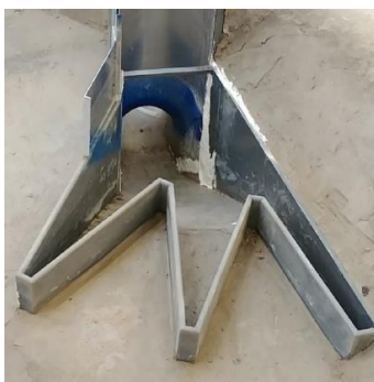
Figure 35 : Vue de l'ouvrage d'entonnement du nouvel EVC
