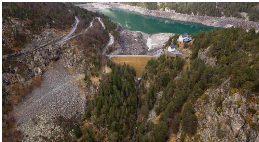
Figure 1 : Vue d'ensemble depuis l'aval du barrage
