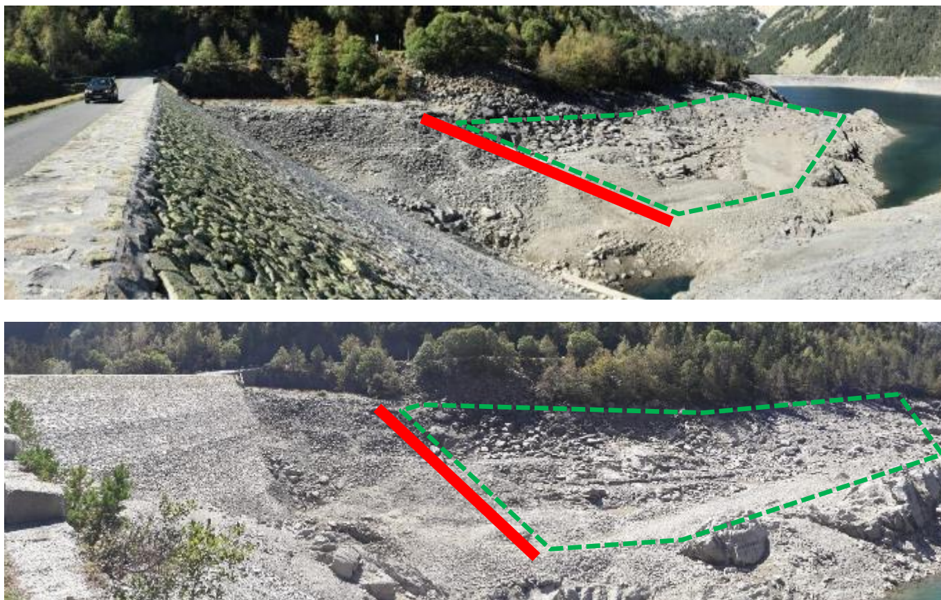
Figure 41 : Zone de stockage des déblais d'excavation
