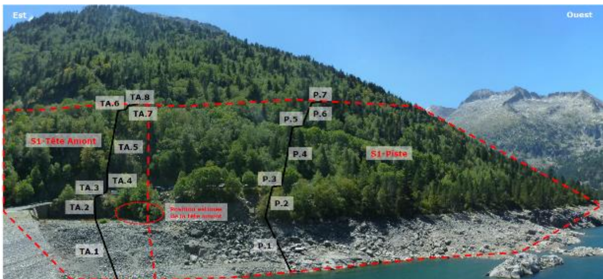
Figure 20 : Vue de la zone S1 amont d'étude pour sécurisation
