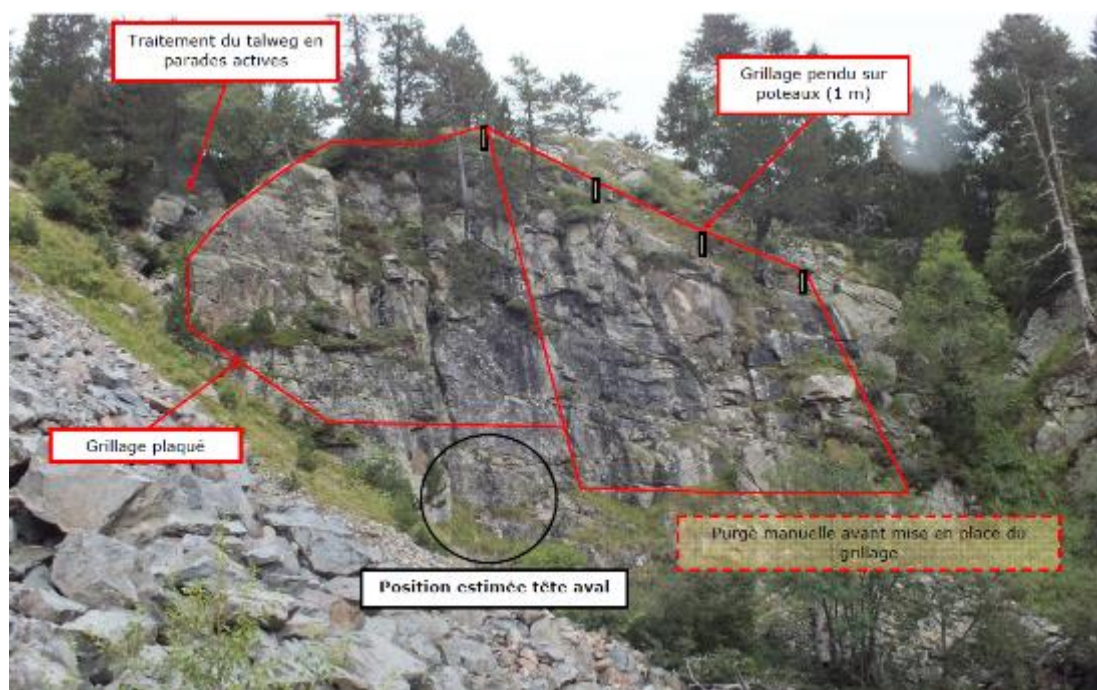
Figure 24 : Vue des ouvrages sur le secteur S2D
